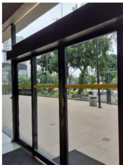
Porta – Acesso dos Servidores – Fachada Principal – Edifício Raul Barbosa
