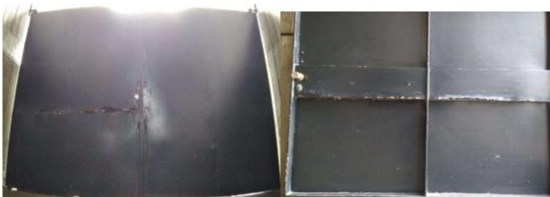
Portão Subsolo – Frente e Verso – Rua Assunção – Edifício Raul Barbosa
