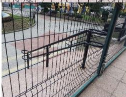
Corrimão de Escada - Fachada Principal – Edifício Raul Barbosa
