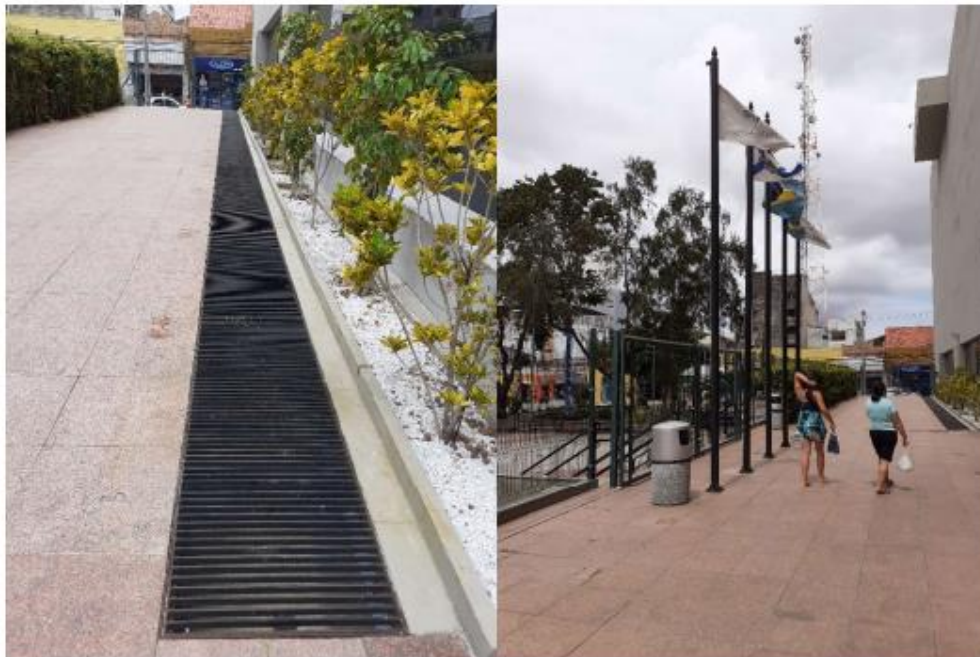
Grelha/Mastros – Fachada Principal – Edifício Raul Barbosa
