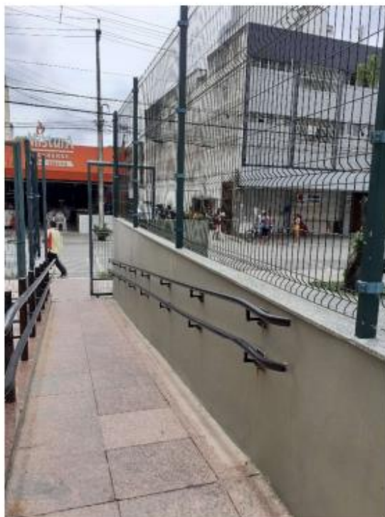
Corrimão Rampas – Rua Assunção – Edifício Raul Barbosa
