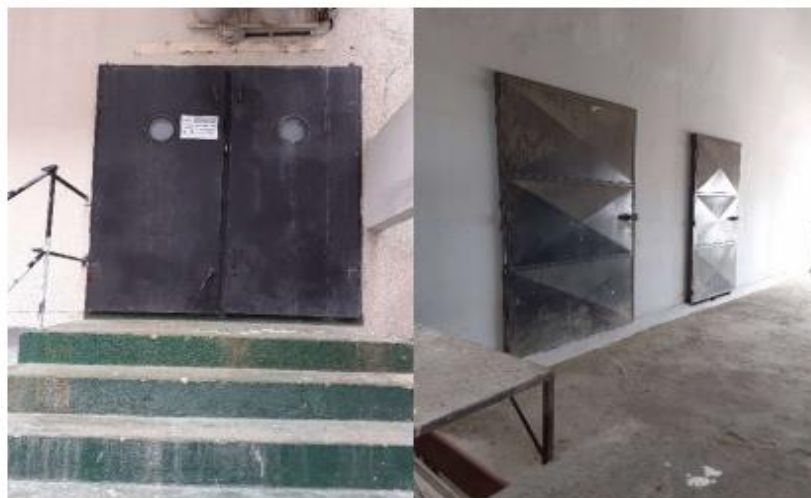
Portões na Cobertura – Edifício Raul Barbosa
